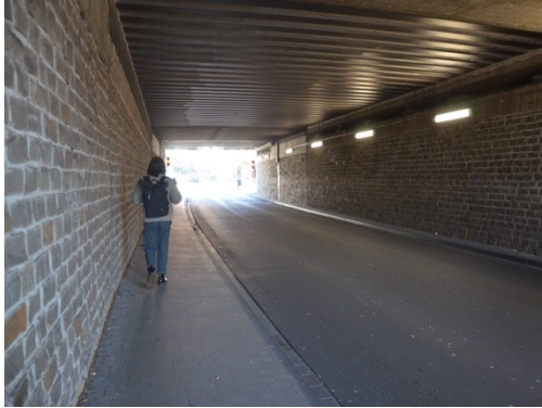
1 Zugang zur Fußgängerzone – Unterführung Sieglarer Straße
