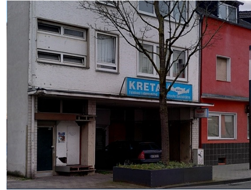
6 Kölner Straße – Stark sanierungsbedürftige Immobilien
