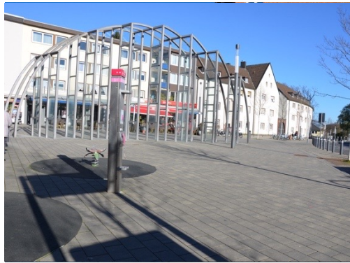
5 Kölner Straße – Stadttor, östlicher Fußgängerzonenauftakt
