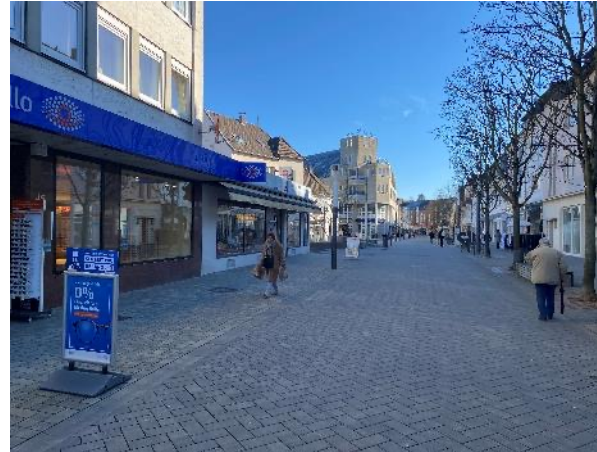
Abb.2: Bepflasterung Fußgängerzone Kölner Str.
