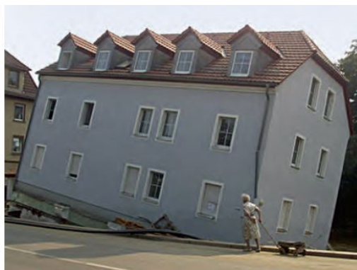
Abb. 8: Aufgeschwommener Estrich und gekipptes Haus durch unterspülen
