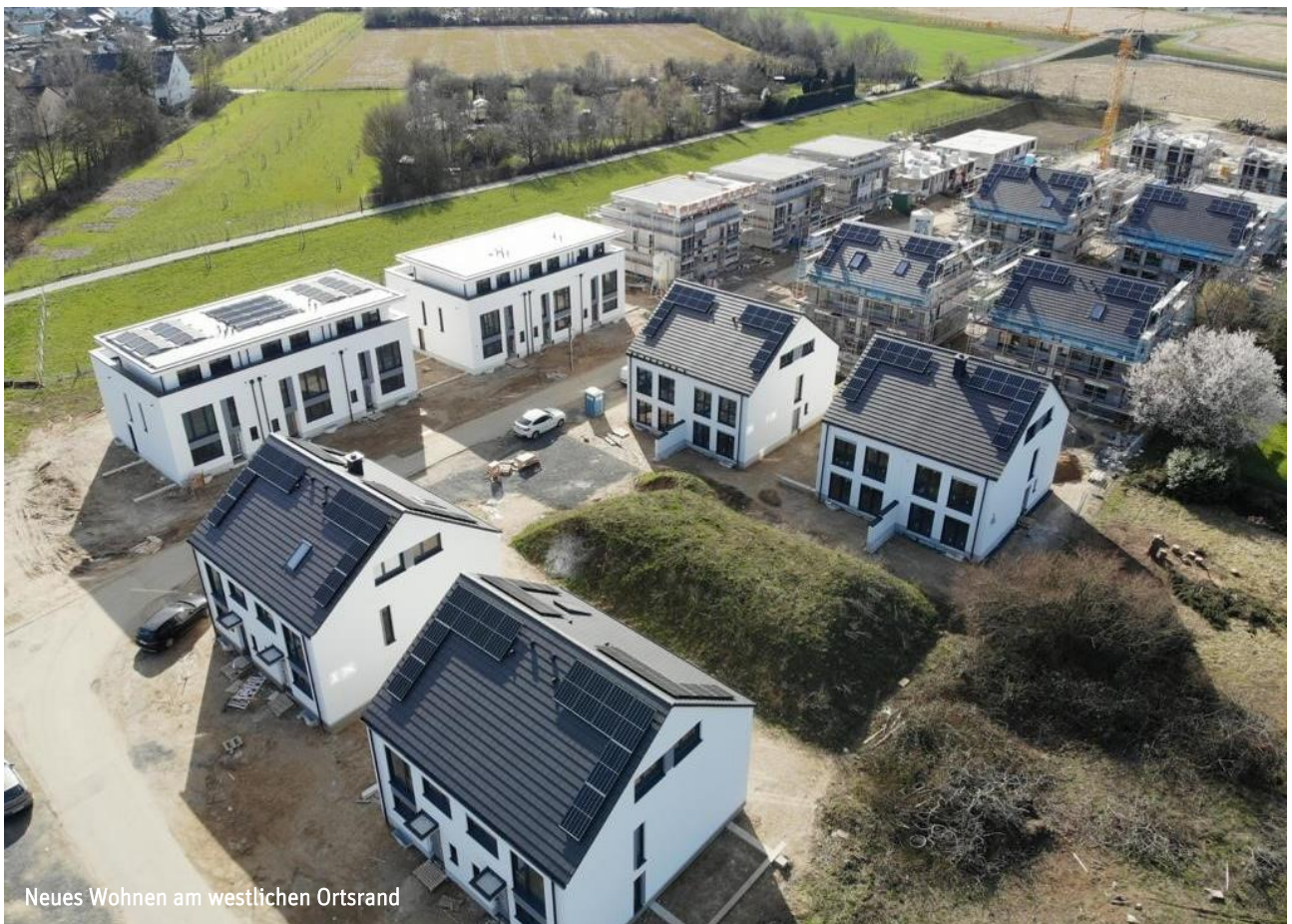
Verbesserungsbedürftiges Ortsbild in der Larstraße
