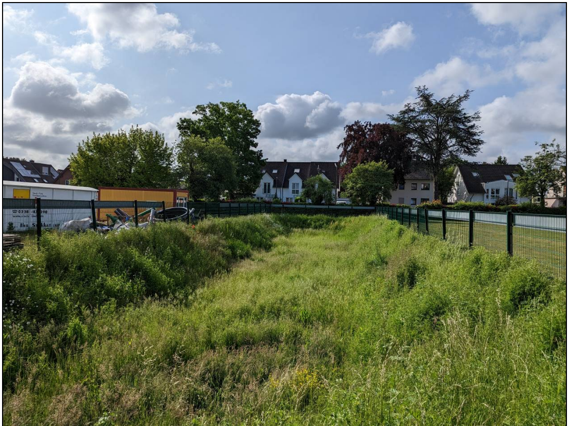
Foto 8: Rückhaltebecken mit Grasaufwuchs ohne Wasseranstaup im Normalfall
