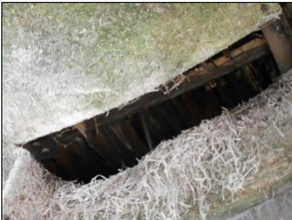
Abbildung 20: Spaltenpotential im Dachbereich von Gebäude durch defektes Dämmmaterial
