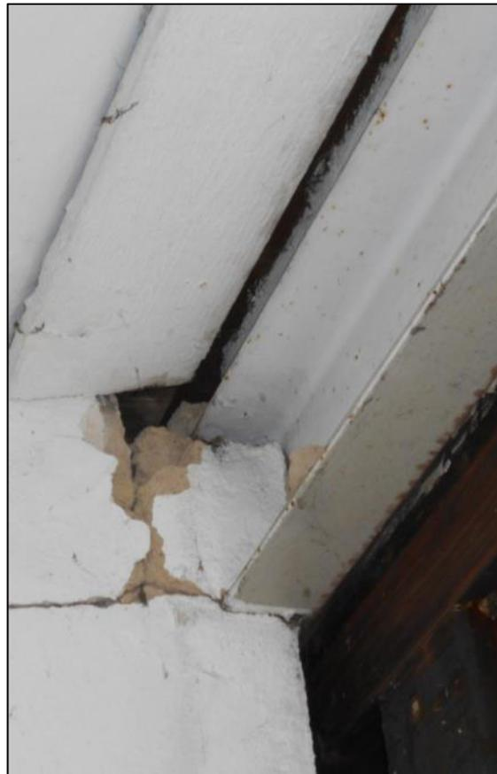
Abbildung 16: Spaltenpotentiale an Wänden in Schuppen durch herausgebrochenes oder verwittertes Material
