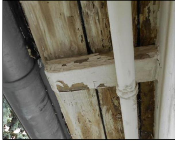
Abbildung 18: Spaltenpotential durch Fugen zwischen den Holzlamellen in Dachüberstand
