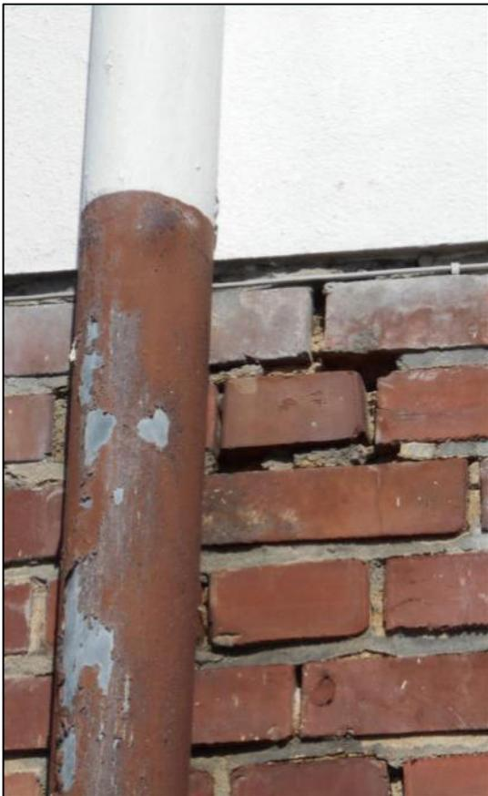
Abbildung 15: Spaltenpotentiale im Gemäuer des Verwaltungsgebäudes an der Süd-Ostfassade durch herausgebrochenes oder verwittertes Material
