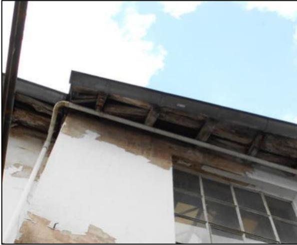
Abbildung 17: Spaltenpotential durch verwitterten Dachüberstand an altem Produktionsgebäude
