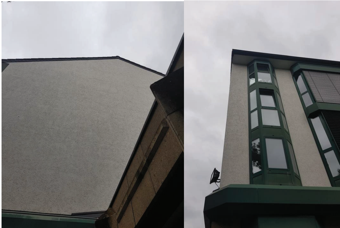
Abbildung 4: Fassade des zurückzubauenden Gebäudens von Osten (links) und Süden (rechts).
