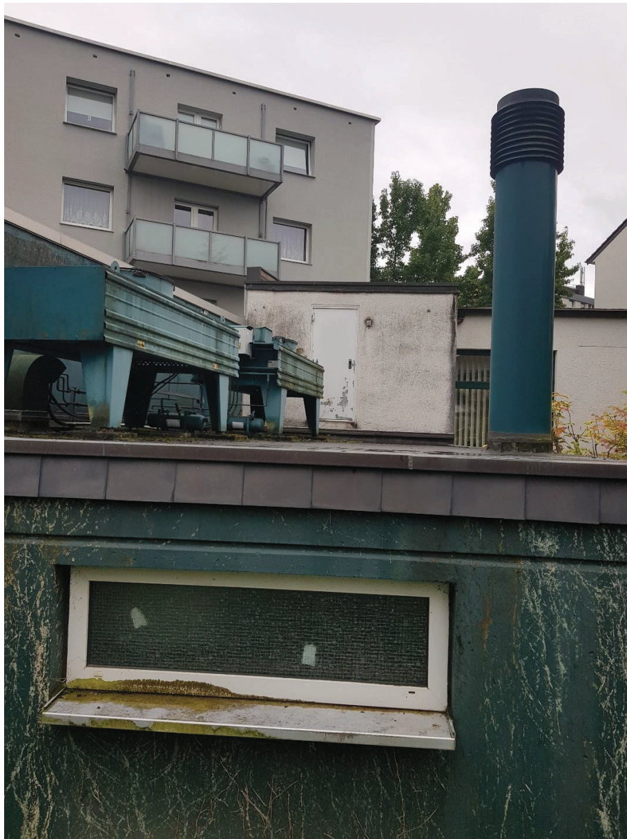
Abbildung 11: Blick auf niedrigere Teile des Flachdaches. Diese waren ohne Nester oder andere Hinweise, die auf eine zurückliegende Brut hingedeutet hätten.
