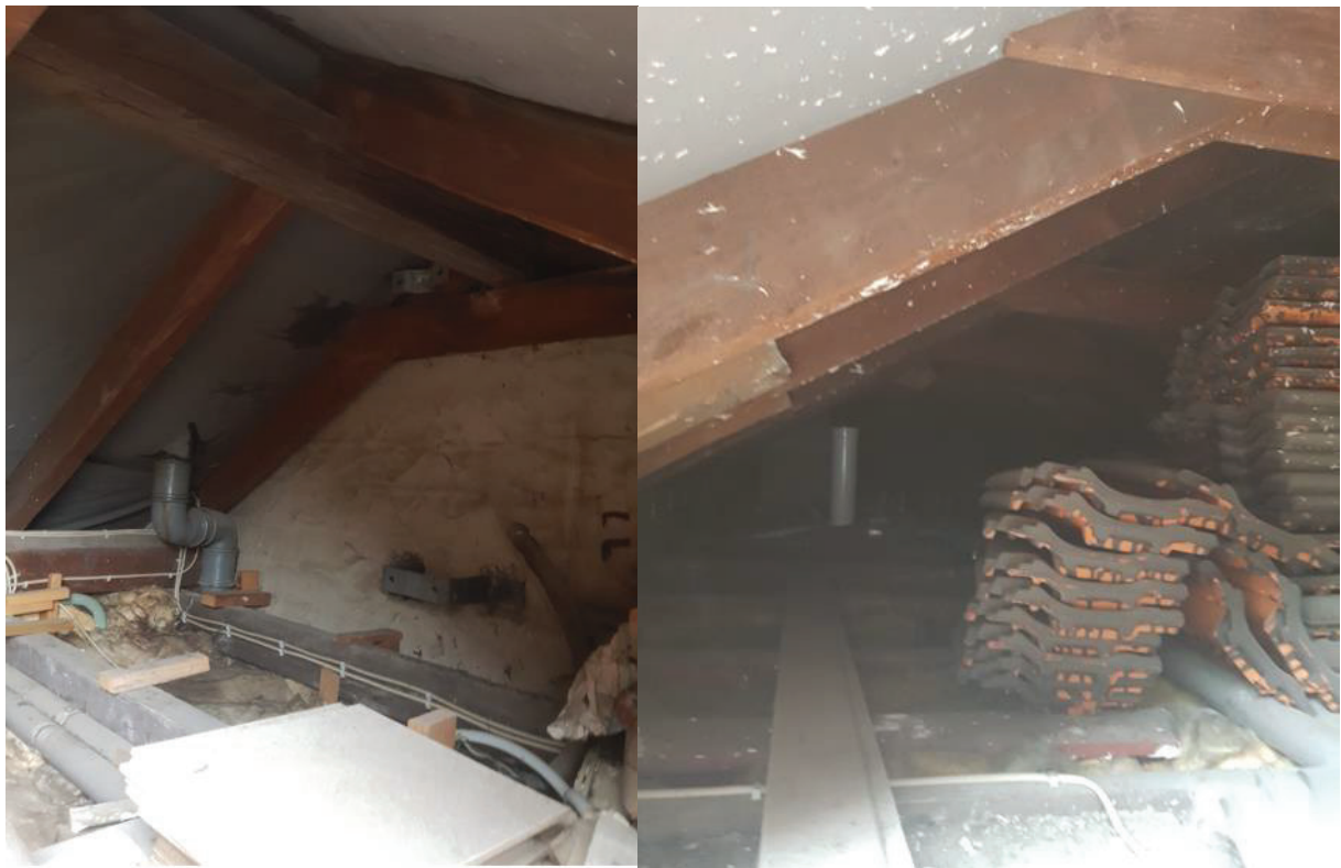
Abbildung 6: Dachstuhl des zurückzubauenden Gebäudes ohne Möglichkeiten eines Einfluges und auch sonst keine Anzeichen einer Quartiernutzung.
