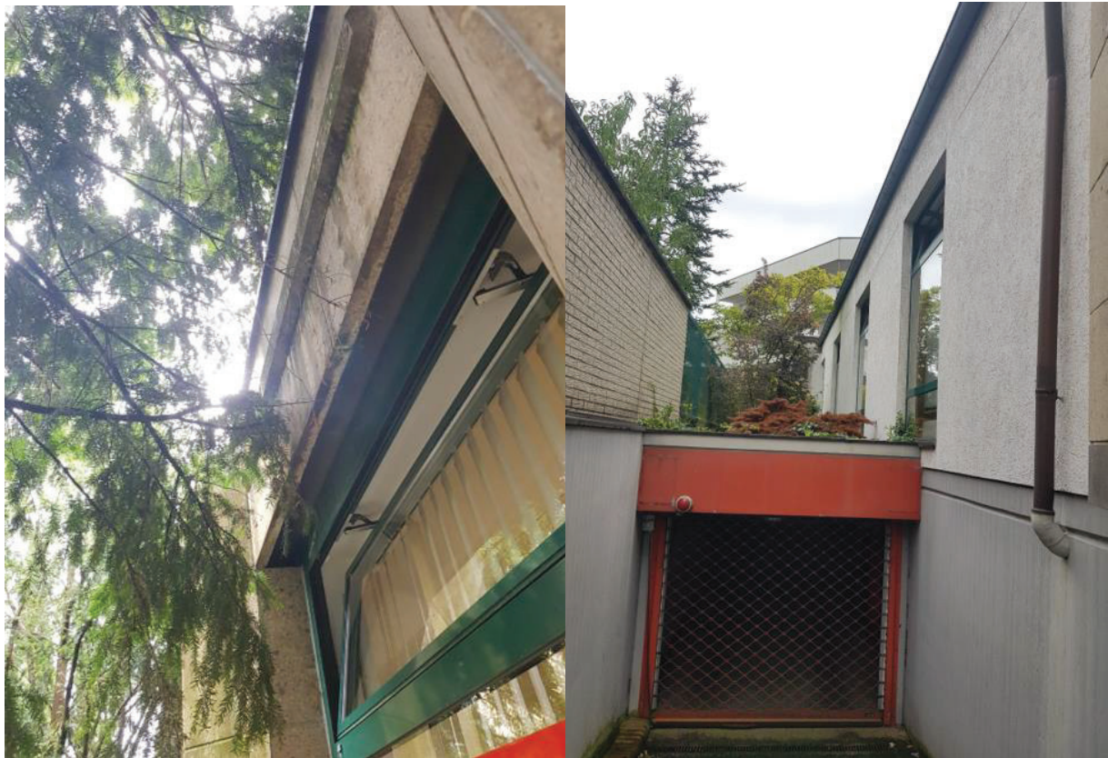
Abbildung 8: Nahaufnahme der Fassade der Sparkasse. Versteckmöglichkeiten für Fledermäuse sind unter der Dachspalte des Flachdachs zwar vorhanden, blieben aber ohne Befund. Der Raum zwischen Fenster und Fassade (links) ist für Fledermäuse unbrauchbar, ebenso der Eingang in die Tiefgarage (mit Blick auf Gemeinschaftsgarten, rechts).
