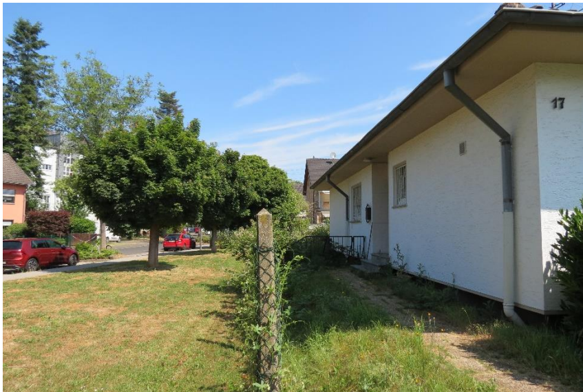
Abbildung 3 - 5: Seiten- bzw. Rückansicht entlang der Gotenstraße 1
