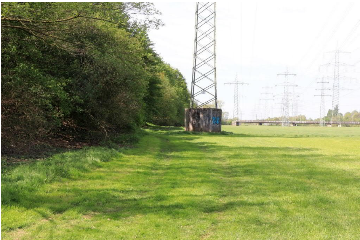
Abb. 6: auf dem rechts des Gehölzsaums verlaufenden Grasweg soll eine mobile Baustraße mit Alu-Bodenschutzplatten verlegt werden.
