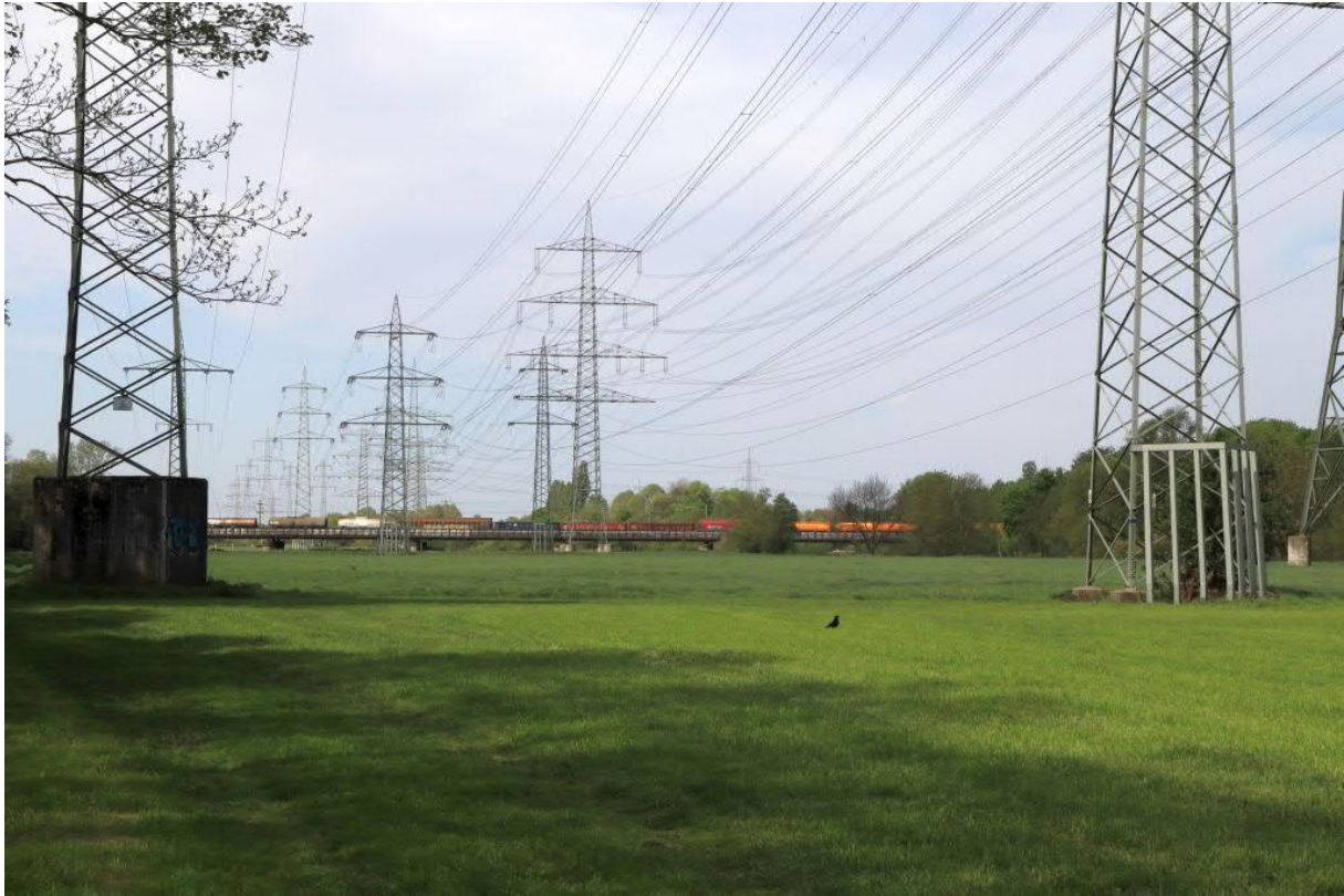
Abb. 5: Blick vom östlichen Rand des Untersuchungsgebiets auf die bestehende Siegbrücke und die Siegaue.
