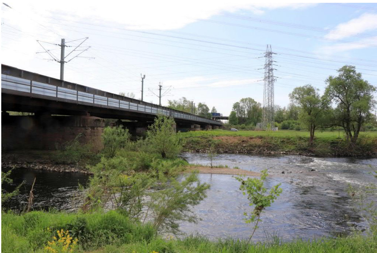
Abb. 2: Blick aus nordwestlicher Richtung auf bestehende Siegbrücke mit Stützpfeiler im Fluss.
