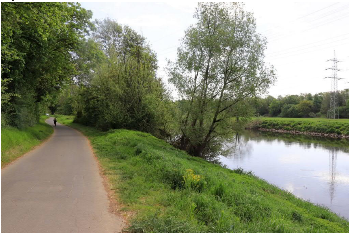
Abb. 4: nördliches Siegufer auf der östlichen Seite mit Uferböschung, Gehölzsaum und Fuß- und Radweg.
