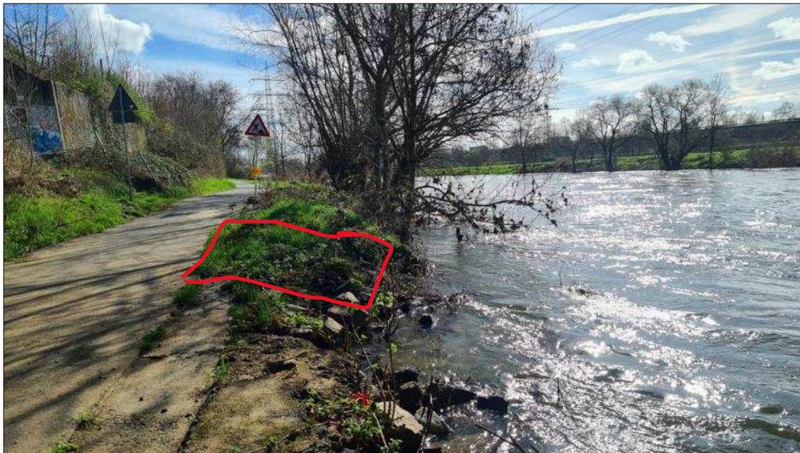
Abbildung 22: Ungefähre Abgrenzung des maximal 3 m breiten Baufeldes. Eingriffe in die Ufersteine der Uferbefestigung sind zwin- gend zu vermeiden (hier im Foto vom 28.03.23 bei höherem Wasserstand gerade überspült; Pegel Menden 149 cm).
