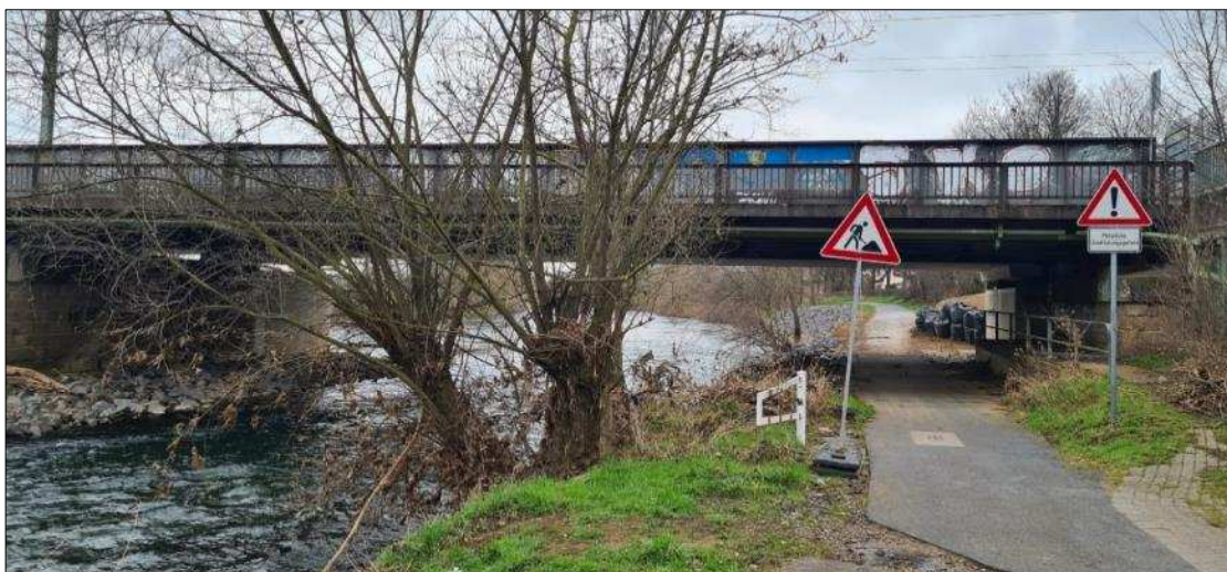
Abbildung 7: Ansicht des Baufeldes für die Stütze 20 (hinter dem Ufergehölz) und für die Rampe (rechts im Bild) aus östlicher Sicht (Foto 07.03.23)
