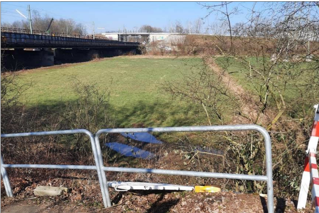
Abbildung 11: Baufeld für die Geh- und Radwegbrücke auf der südlichen Siegseite östlich der Bahnbrücke in Richtung Norden; das Ufervorland befindet sich hier außerhalb des FFH-Gebietes)
