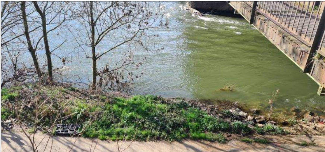
Abbildung 9: Baufeld für Stütze 20 am Siegufer oberhalb der Wasserlinie bei höherem Mittelwasserstand aus nördlicher Sicht (Foto 28.03.2023)
