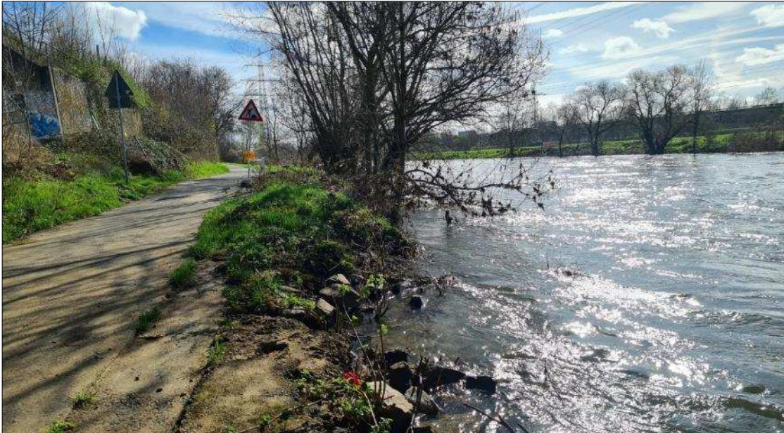
Abbildung 8: Ansicht des Baufeldes für die Stütze 20 (Grasfläche vor dem Ufergehölze) aus westlicher Sicht (Foto 07.03.23)
