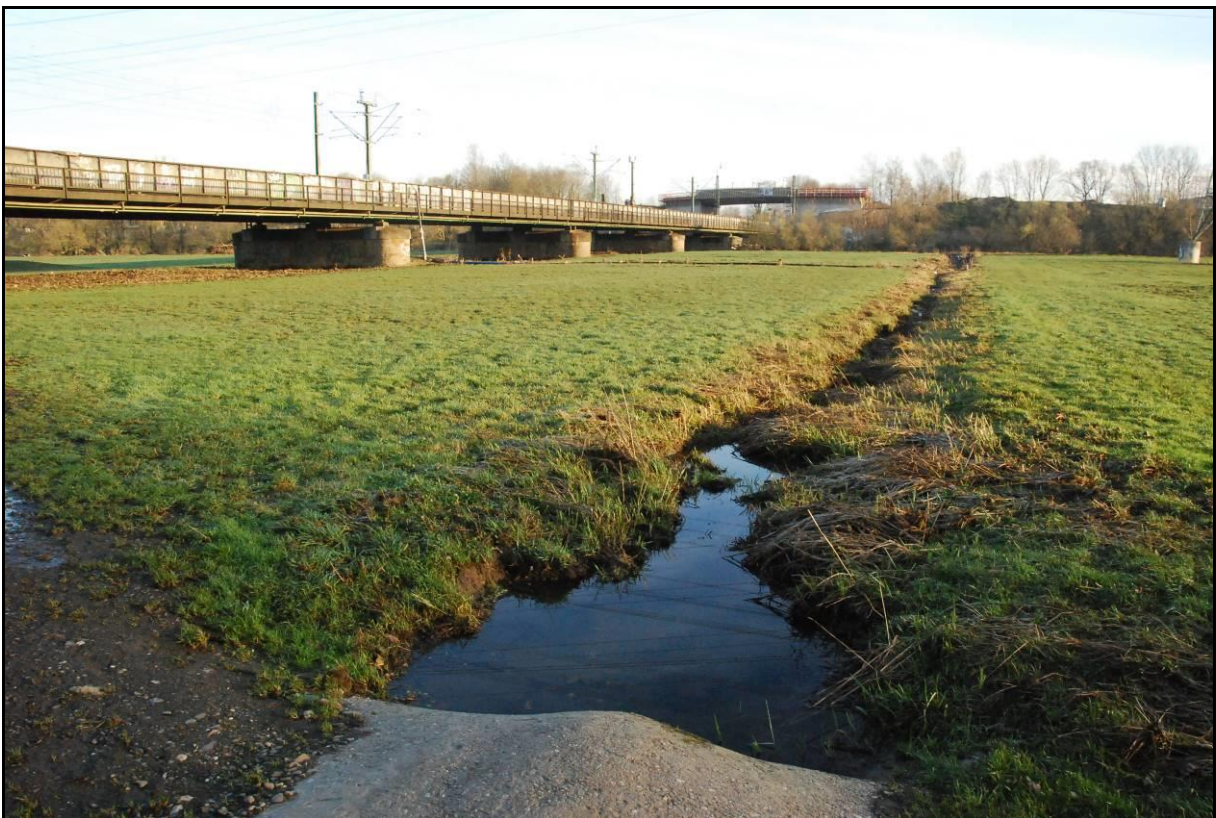
Abb. 7: An der Grenze des westlichen Vorhabensbereichs verläuft ein temporär wasserführender, kleiner Wiesengraben, der für Amphibien ein potenzielles Laichhabitat darstellt.
