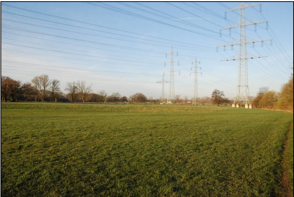
Abb. 10: Westlich des Vorhabensbereichs liegen größere Grünlandflächen, die teils beweidet werden. Die Freileitungen setzen sich hier fort. Rechts im Bild der flussbegleitende Gehölzbestand entlang der Sieg.
