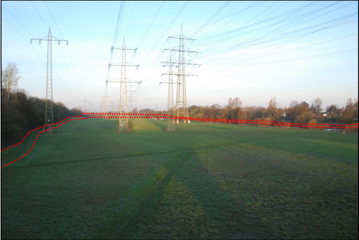
Abb. 2: Blick von der Siegbrücke bzw. Siegstraße auf den Vorhabensbereich (rot markiert). Die Baustellenzufahrten südlich und nördlich der Sieg rahmen hier das Grünland der Siegaue ein (alle Fotos: März 2019).
