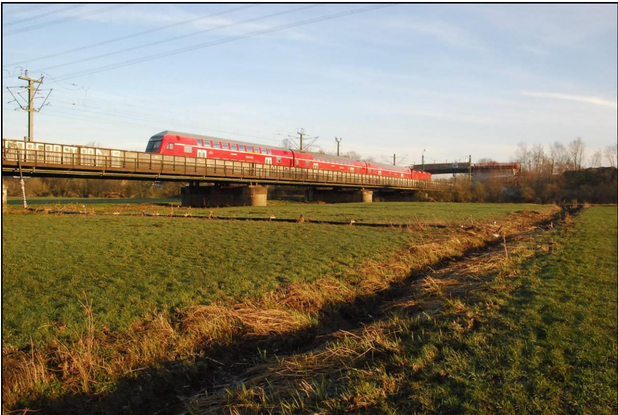
Abb. 3: Blick in den westlichen Vorhabensbereich aus dem Grünland südlich der Sieg. Im Bildvordergrund soll parallel zur bestehenden Eisenbahnbrücke die Geh- und Radwegbrücke gebaut werden.
