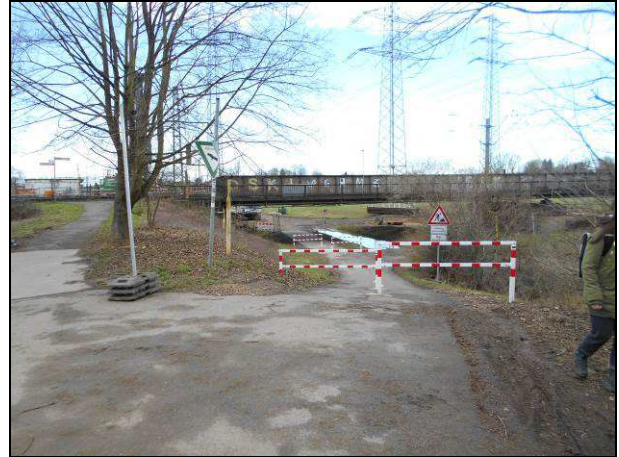
Abbildung 3: Anschlussbereich der geplanten Brücke auf Sankt Augustiner Seite (Feb. 2020)
