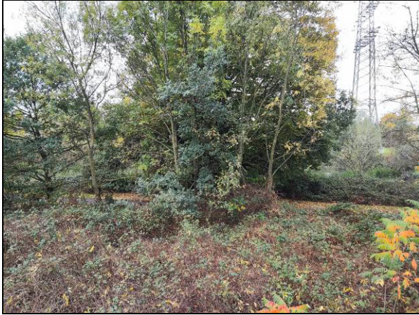
Abbildung 6: Geplante Baustellenzufahrt von der Mendener Straße aus. Blick in Richtung Siegtalweg und Sieg (Okt.2022)
