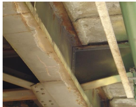
Bild 27: Bestehende Konsole (EÜ Sieg) – Verbindung mit den Nieten – Ostseite
