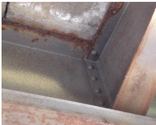
Bild 27: Bestehende Konsole (EÜ Sieg) – Verbindung mit den Nieten – Ostseite
