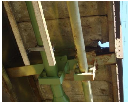
Bild 19: Bestehende Konsole (EÜ Sieg) – Gehwegbelag und Stahlbetonplatte – Ostseite
