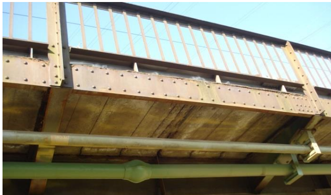
Bild 29: Geländer der bestehender Konsole (EÜ Sieg) – Ostseite
