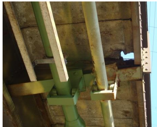
Bild 26: Bestehende Konsole (EÜ Sieg) – Gehwegbelag und Stahlbetonplatte – Ostseite
