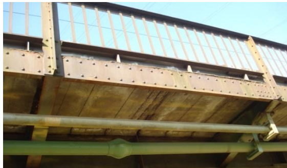
Bild 23: Bestehende Konsole (EÜ Sieg) – Geländer – Ostseite
