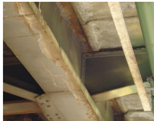
Bild 20: Bestehende Konsole (EÜ Sieg) – Verbindung mit den Nieten – Ostseite
