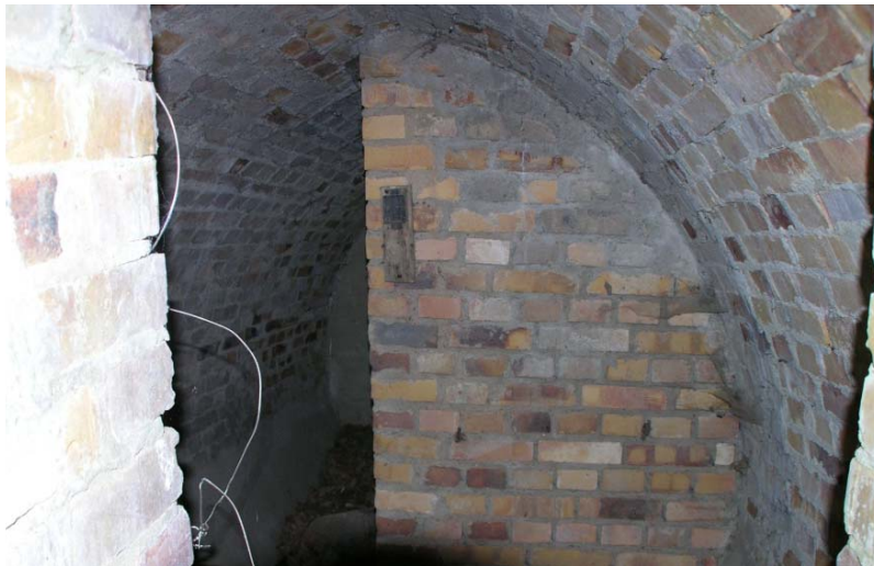
Abbildung 7: Blick in Luftschutzstollenanlage
